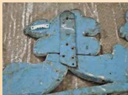
Foto 3: Pormenor de intervenciones antiguas
